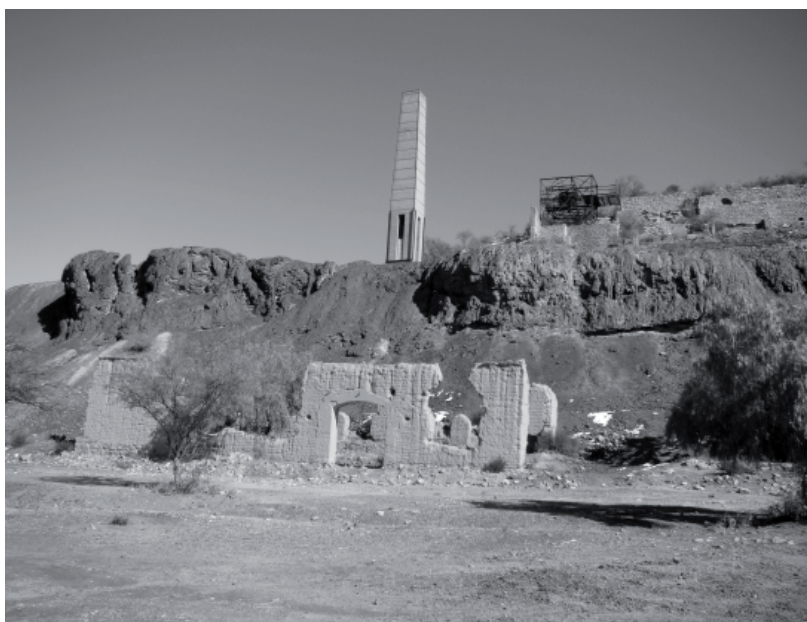
Figura 1. Ruinas del Ingenio Santa Florentina (Chilecito). Restos de construcciones, chimenea, escoriales y estación del cablecarril
